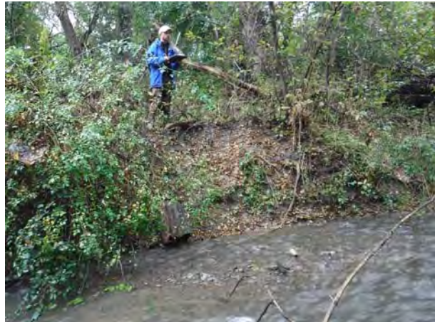
Erosion Site 3 Photo 4.JPG
