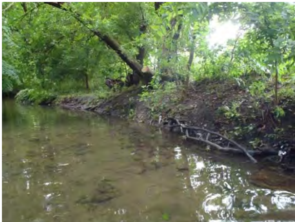
Erosion Site 1 Photo 3.JPG
